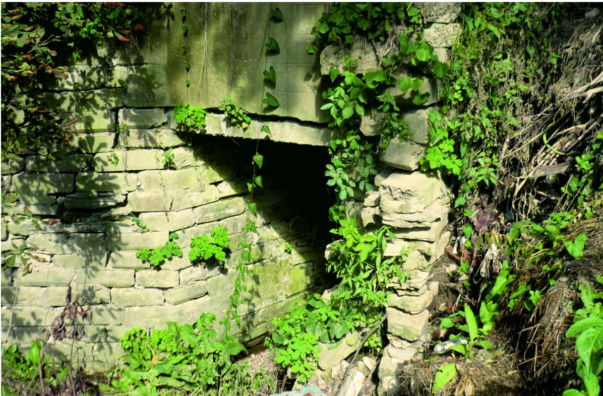
Опоры моста из еврейских надгробий
